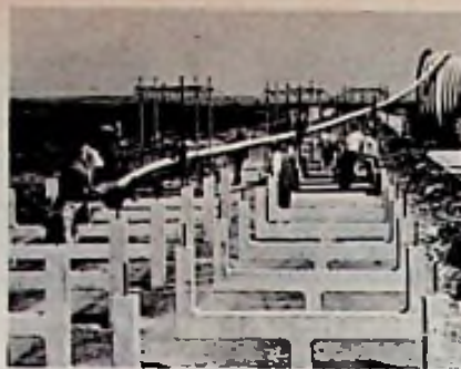
Afb. 4. De kabel wordt van de trommel in het kabelkanaal gevoerd.
